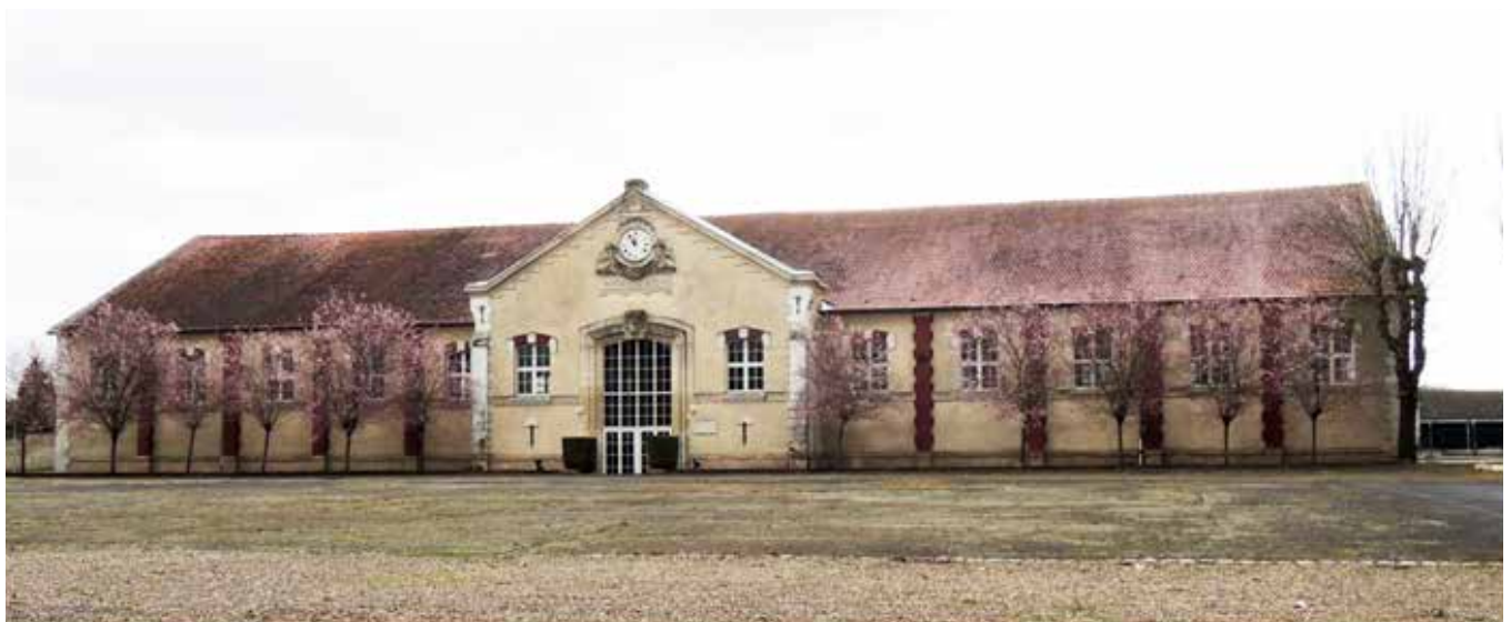
図1 バイオミメティクス拠点のコンファレンスセンターとなる建屋
